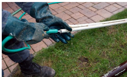
Rinçage de la pompe air-lift par de l'eau propre
