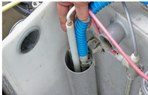
Enlèvement de la pompe air-lift (pompe à air), du filtre à grosses impuretés – voir fig. 1, no. 4 du guide (localisation du filtre à grosses impuretés dans la mini station)
